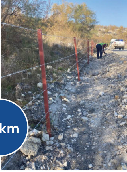
Resim 9. Ağaçlandırma bölgelerindeki Tel Çit Yapımı
